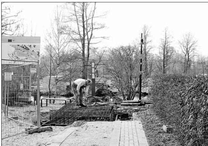
Ein Gerüst wurde benötigt, um die bis zu 11 Meter langen Betonpfähle als Gründung für die Brücke einzubringen. Der Brückenaufbau selbst wird aus Holz bestehen, wie bei den anderen Brücken und Bänken über die Fließe der Stadt auch. Mit 107 Metern Länge wird das barrierefreie Bauwerk eine der längsten Fußgängerbrücken im Spreewald sein. Drei sogenannte Kanzellen, mit denen die 2 Meter breite Brücke versehen wird, sollen den Spaziergängern als kleine Aussichtsflächen dienen, von
