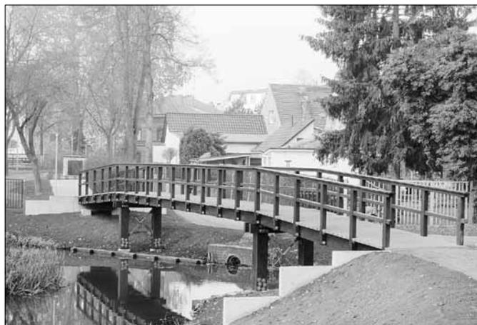
Obwohl mit 24 Metern Länge und 1,50 Meter Breite nicht so imposant wie die Brücke am Wasserwanderstützpunkt, kann sich das rund 190 000 Euro teure Bauwerk durchaus sehen lassen. Zusammen mit der dahinter liegenden Brücke, bei der die Treppen entfernt und durch Rampen ersetzt wurden, stellt sie nun eine bequeme Verbindung für Radfahrer und Fußgänger zwischen der Puschkinstraße über den Stadtgraben zum Damm her.
