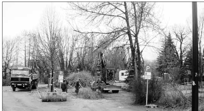
(Vor wenigen Tagen wurden in Vorbereitung der Maßnahme Bäume gefällt)
