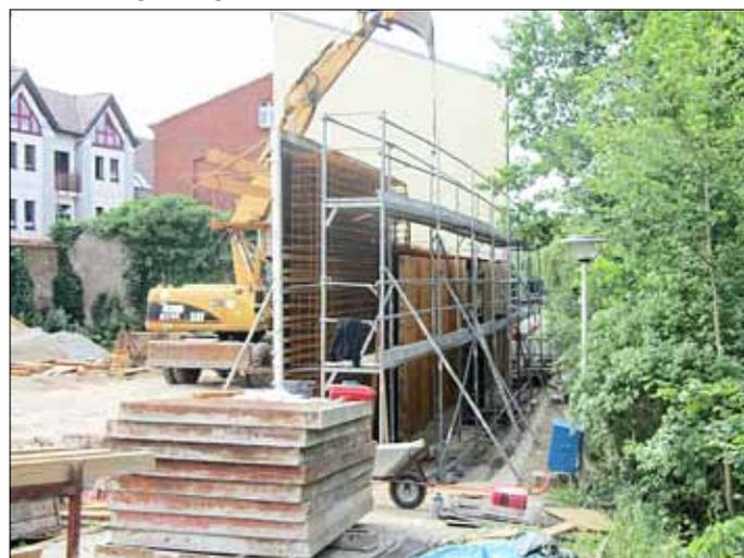
Am südlichen Teil wurden zunächst einige Klinker als Probe angebracht, um zu schauen, welche Fugenart man für die gesamte Mauer nimmt.
