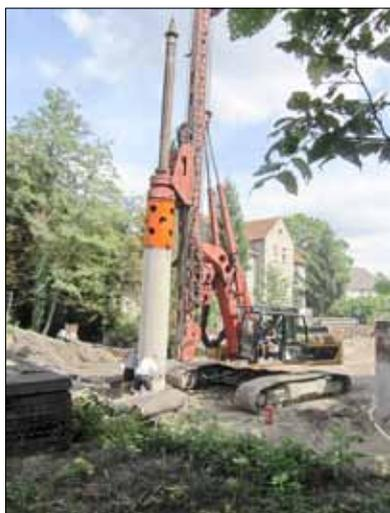
Gespannt verfolgten Zuschauer, wie der erste von mehreren Betonbohrpfählen, die als Fundament für die Brückenunterkonstruktion des Bauwerkes in der Bahnhofstraße dienen, durch die Firma Strabag AG eingebracht wurde. Rund 477 000 Euro kostet der Brückenbau, der aus dem Förderprogramm des Landes Brandenburg zur Verbesserung der Verkehrsverhältnisse der Gemeinden. - Teil kommunaler Straßenbau- bezuschusst wird.
