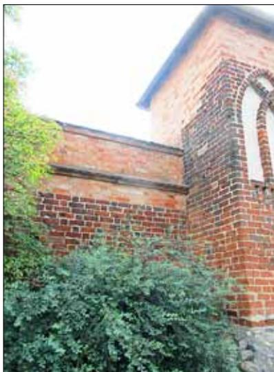
Moderner, aber dennoch dem alten Mauerwerk angepasst ist die Gestaltung der Wände des kleinen Hofes am Trutzer mit ihren horizontalen Vertiefungen und dem glatten oberer Abschluss.
