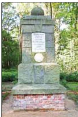
Der Zahn der Zeit hatte bei dem Denkmal im Hain, das den Opfern beider Weltkriege gewidmet ist, sichtbare Spuren hinterlassen - der Sockel aus Ziegelmauerwerk war kaputt und auf den Steinen mit der Inschrift hatte die Witterung einen grünen Belag hinterlassen.
