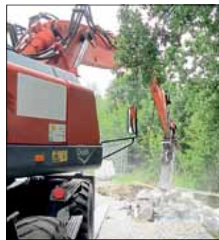
Nach dem Abriss des Holzbrückenkörpers wurden vor wenigen Tagen die oberen Teile der Widerlager abgerissen, um später auf den verbleibenden Teilen neu aufzubetonieren.
