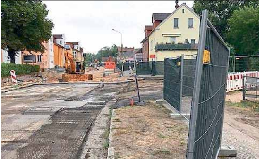
Der nächste Bauabschnitt in der Bahnhofstraße wurde eingerichtet. Foto: Steffen Bergmann
