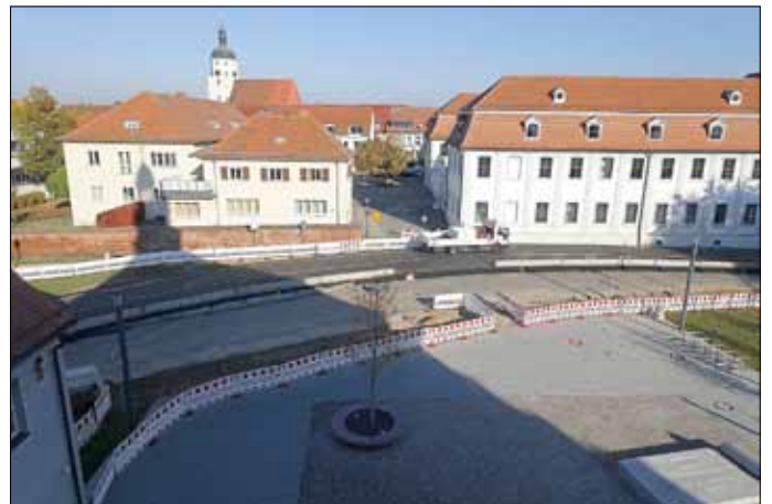
Wenn die Südhälfte der neuen Fahrbahn fertig ist, wechselt die Baustraße dorthin.
