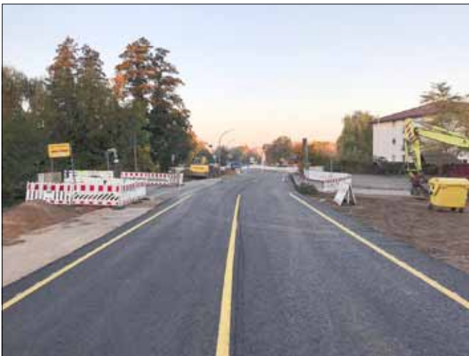
Die während der Vollsperrung hergerichtete Baustraße führt zweispurig an der Baustelle vorbei.
