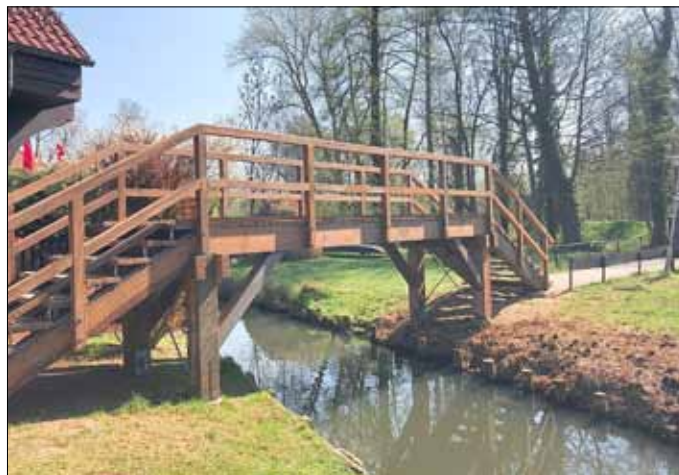
... und für die Sanierungen von Brücken zuständig.
