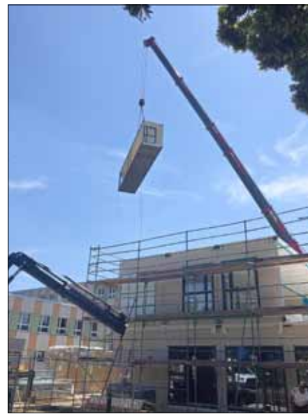
Mit Spezialtransporten wurden die 24 Module angeliefert.
