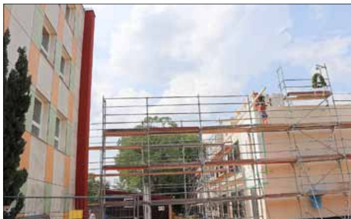
Der Verbindungsgang zum Hauptgebäude fehlte zu Schuljahresbeginn noch ...
