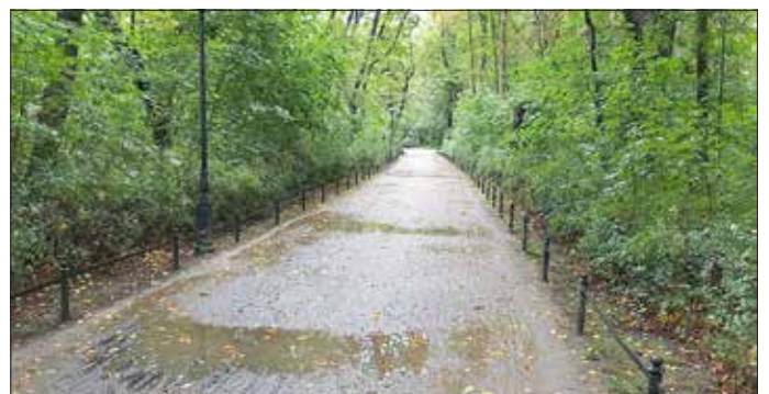
Der Hauptweg durch den Hain soll teilbefestigt werden.
