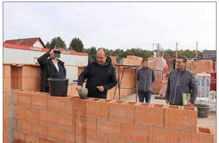
Bürgermeister Lars Kolan verschließt das Fach mit Beton.
