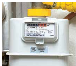
Gaszähler: Nur die schwarzen Ziffern (VOR dem Komma) werden abgelesen.
