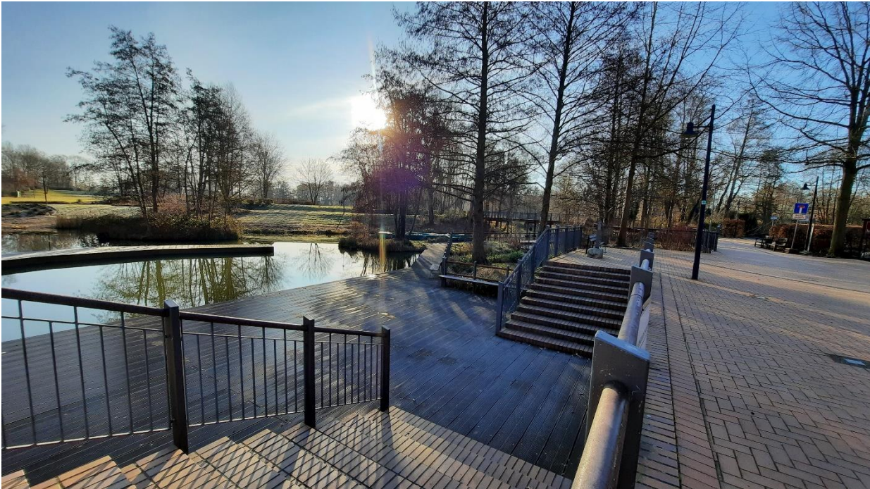
Abbildung 12: Blick auf die Zentrale Steganlage, Stadt Lübben, K. Pötschick
