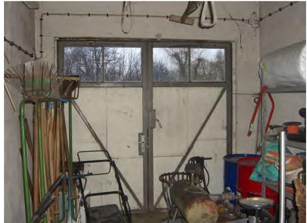
in Eigenleistung gedämmtes Garagentor
