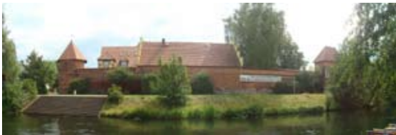
Abb.10 Stadtmauer mit Hexenturm und Trutzer
